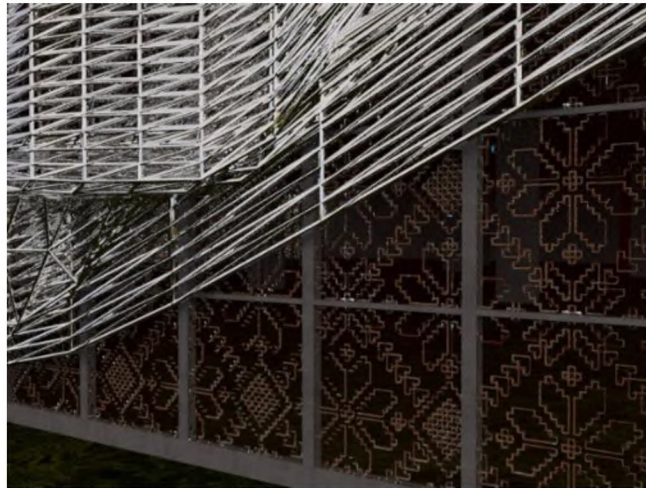
Рис. 4.5. Традиційний візерунок на склі фасаду
