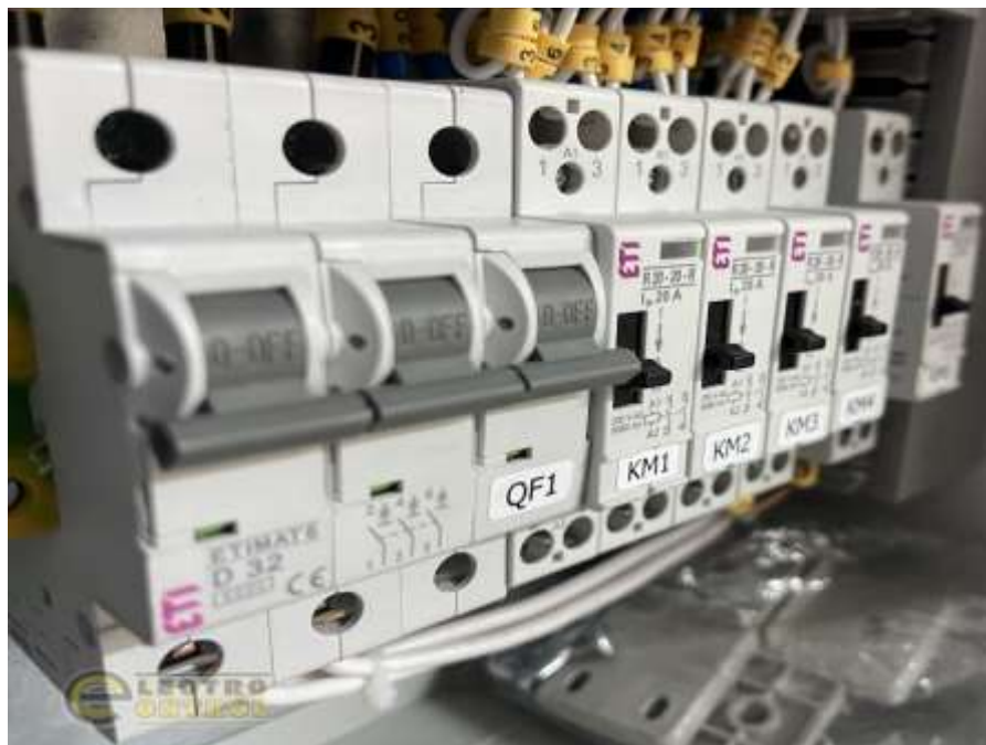
Рис.2.13 Щиток управління освітленням
