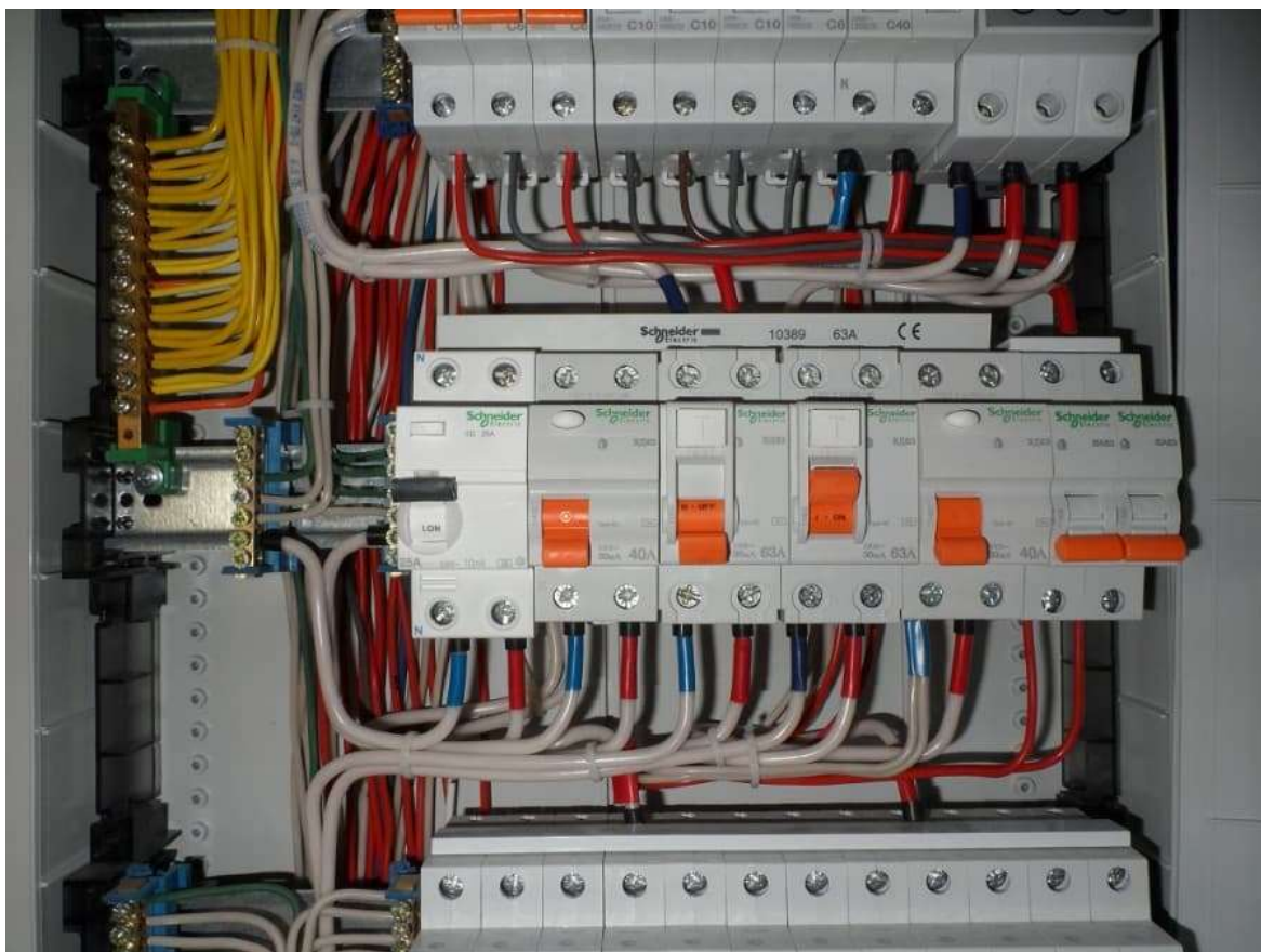
Рис. 2.9 Розподільний щиток
