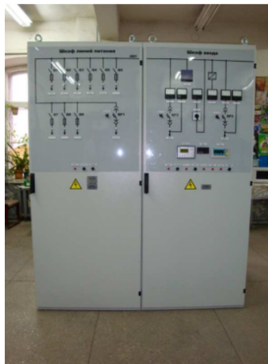
Рисунок 1.5 – Фотографія низьковольтної шафи ШНВ-1
