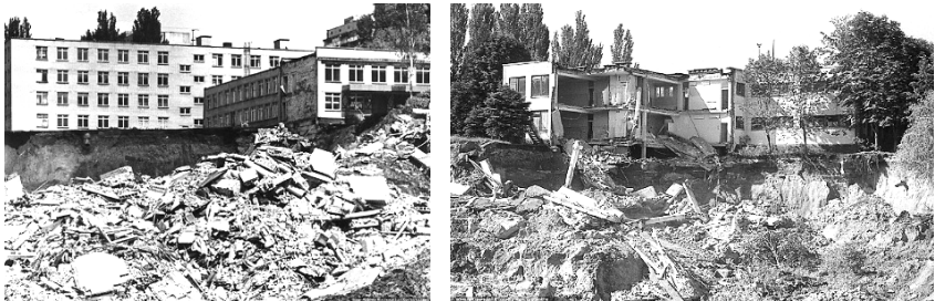
Рисунок 5 — Наслідки зсуву на ж/м Тополя (23.02.2002 р.)
