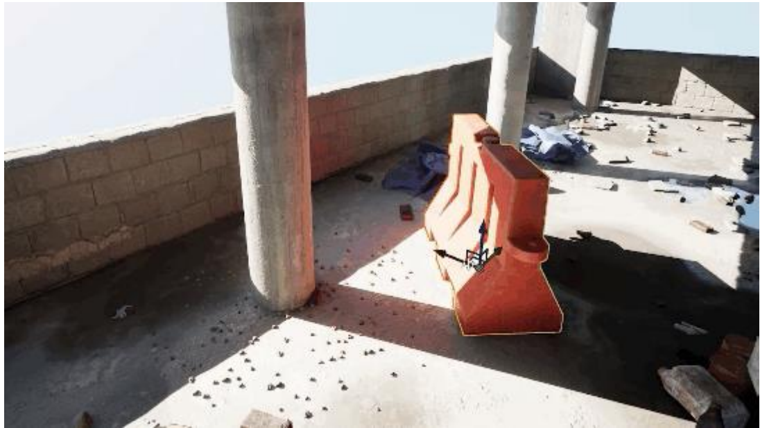
Рис.1.2 Ледь помітне розтікання кольору на колонні
