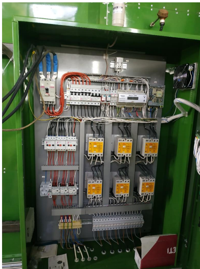
Рисунок 3.3 – Шафа розміщення апаратно-програмного модуля керування камерою полімеризації
