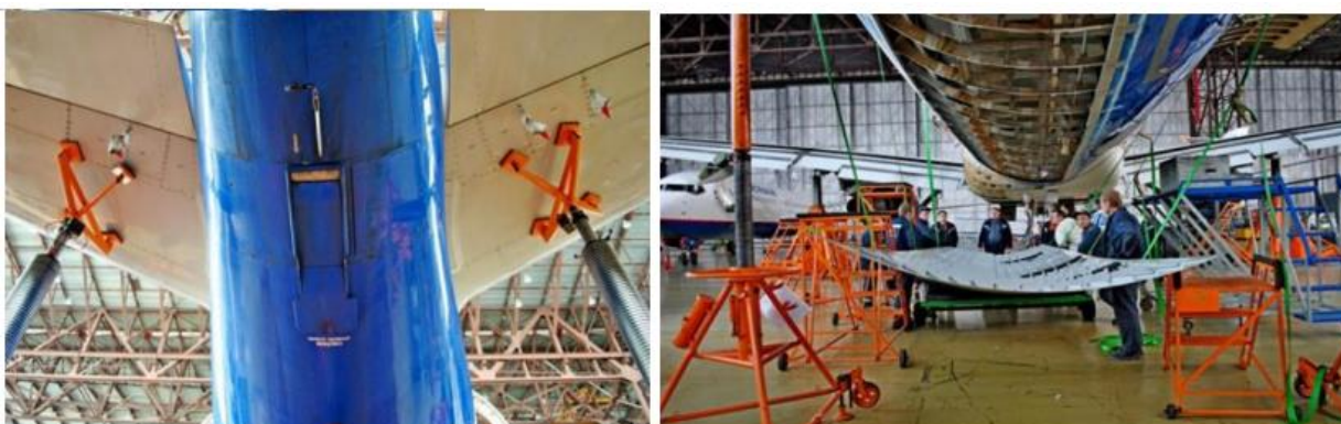
Рисунок 3.1 - Процес підготовки фюзеляжу до ремонту (а) і зняття обшивки каркаса фюзеляжу (б)
