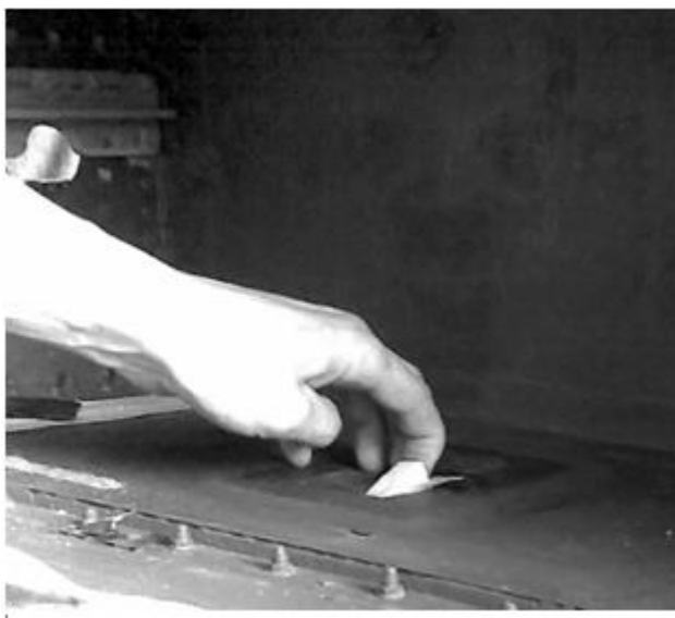
Рисунок 3.14 - Встановлення пінопласту під час ремонту трубчастого заповнювача
