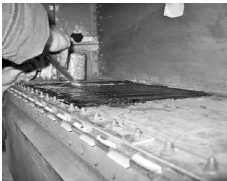
Рисунок 3.8 - Нанесення клею ВК-9 під час встановлення шарів ремонтної накладки
