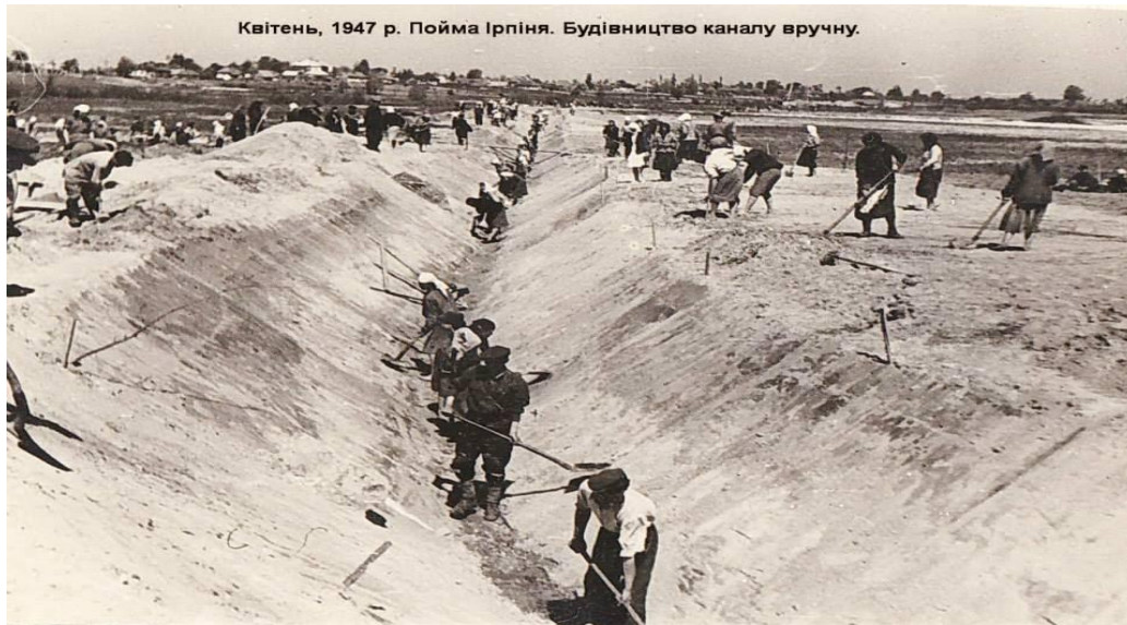
Рис. 1.2 Квітень, 1947 рік. Будівництво каналу вручну.
