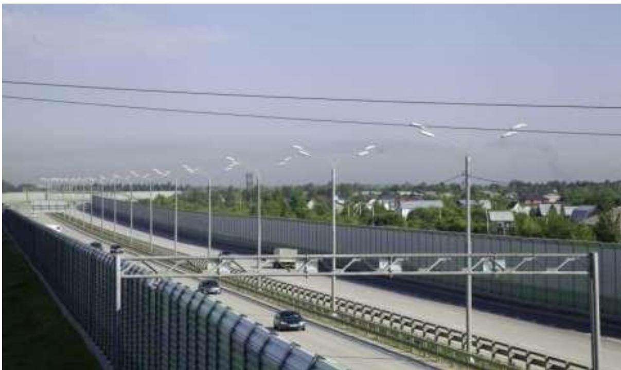
Рис. 4.3. Приклад екрануючих шумозахисних споруд вздовж автомагістралей
