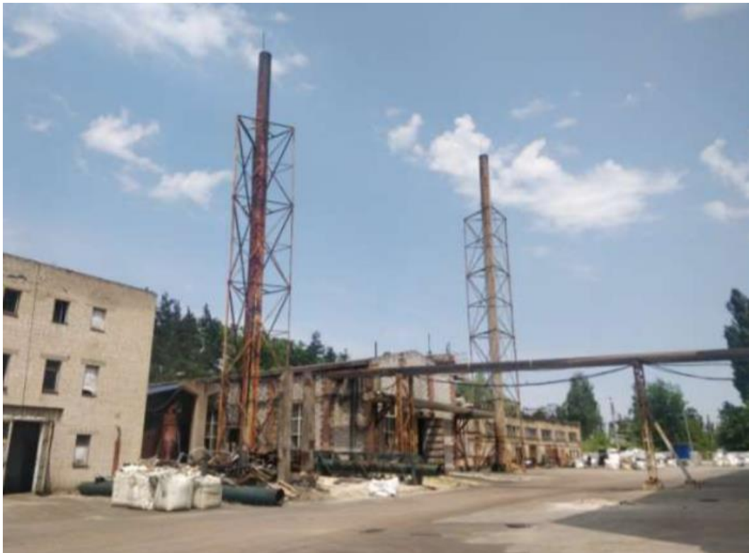
Рис. 4.1. Котельня ТОВ «Ековтор»
