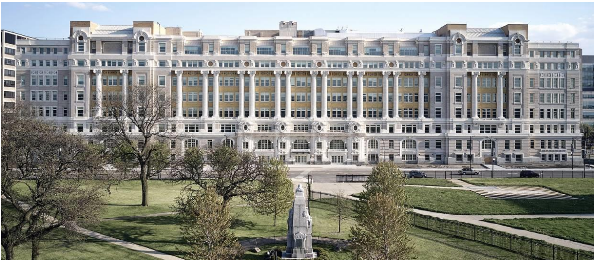
Рис.1.42. Стан споруди після реконструкції
