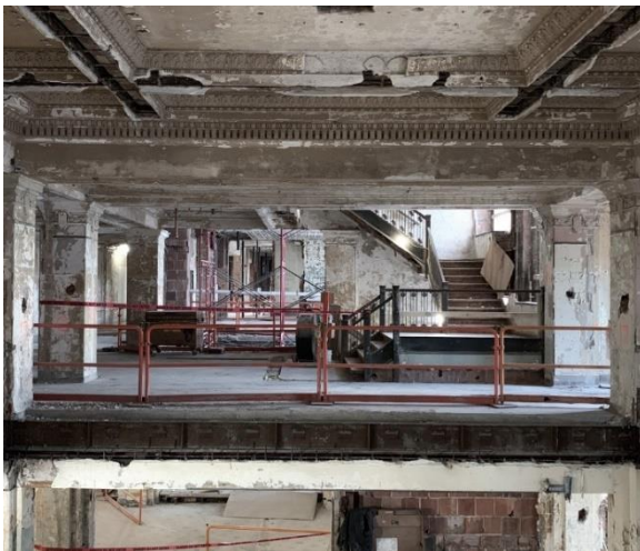
Рис.1.43. Стан внутрішньої частини споруди після реконструкції
