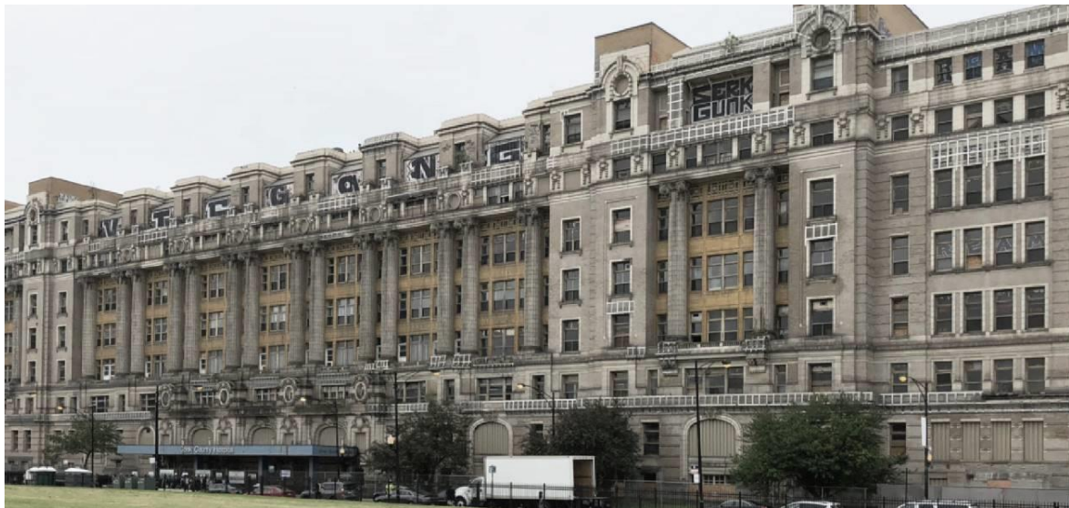
Рис.1.41. Стан споруди до реконструкції
