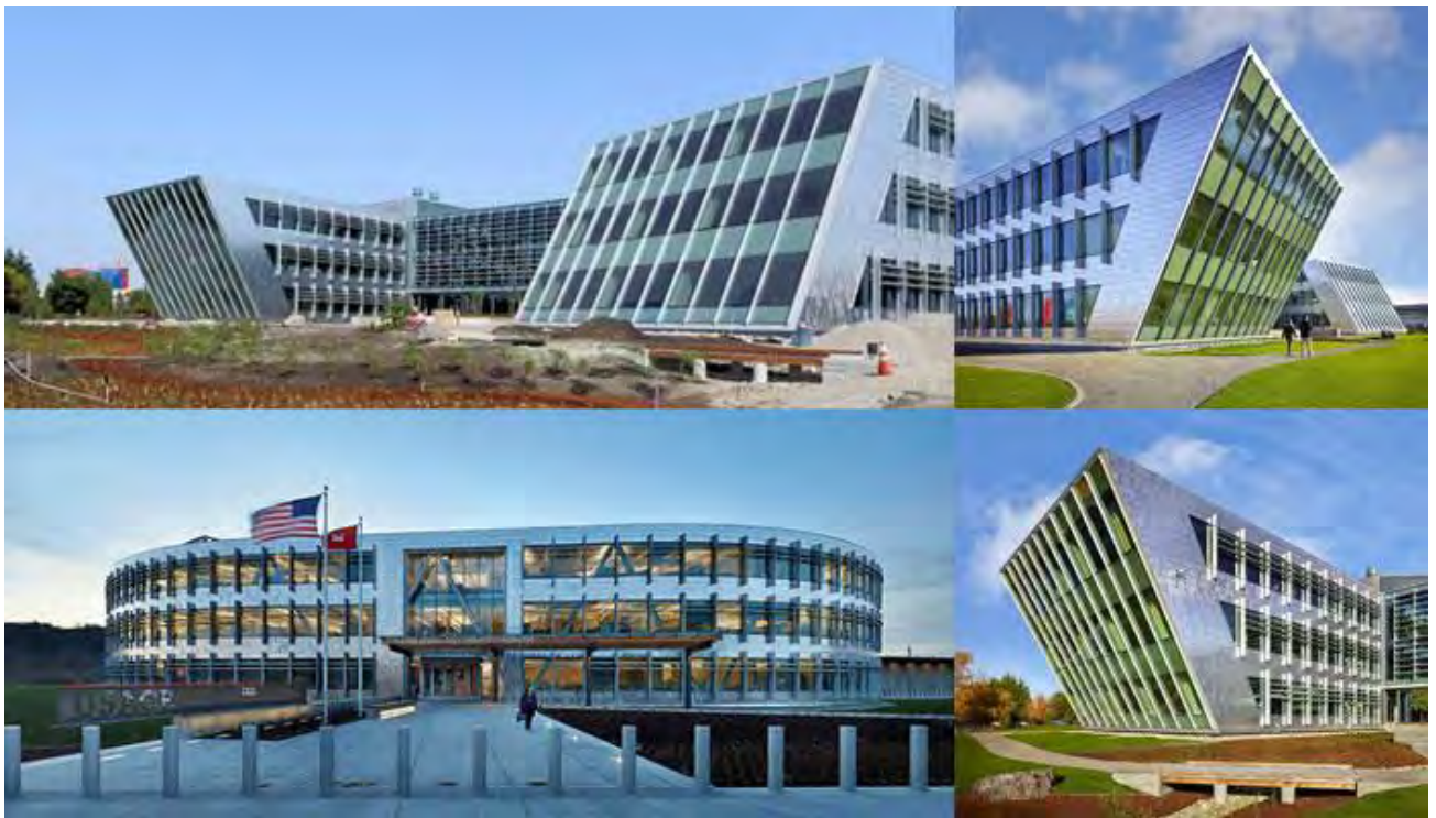
Рис.1.1 Зображення будівлі з різних сторін
