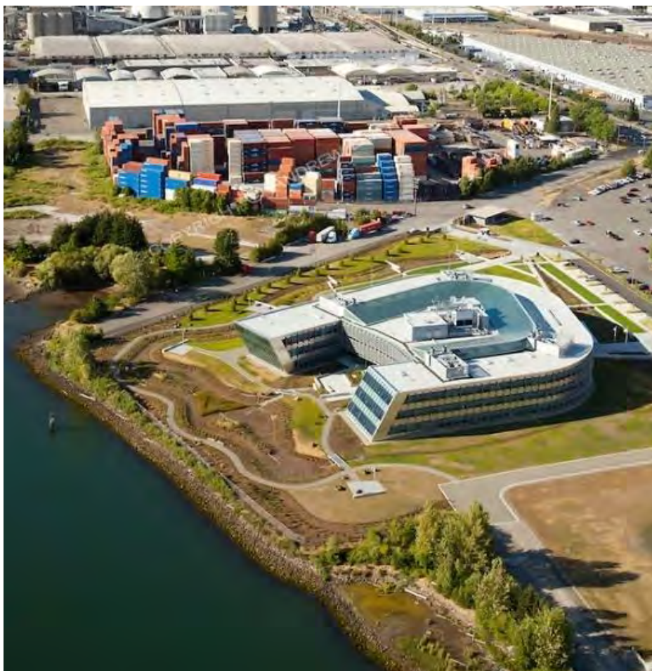
Рис.1.2 Вид зверху на будівлю
