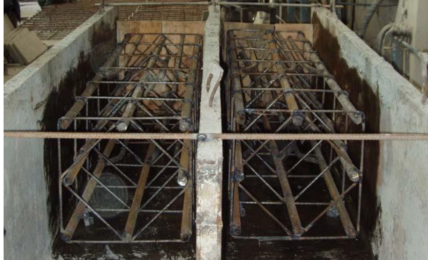
Рисунок 3.1 – Встановлення арматурних каркасів в опалубку
