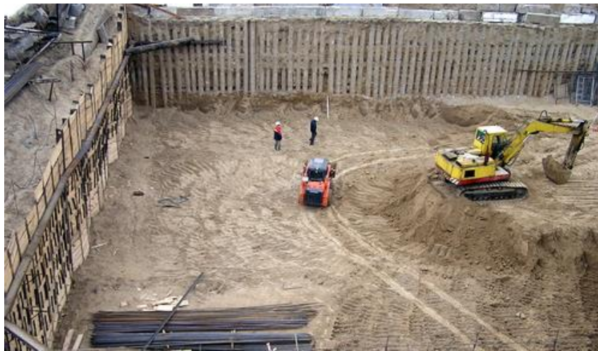
Рис.3.27. Огородження будмайданчика при розробці котловану
