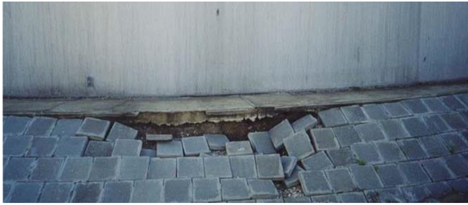
Рис. 2.3. Зона з'єднання стінки з днищем резервуару
