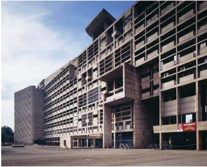
Рисунок 7.1 — Фасад Парламенту штату Пенджаб в м. Чандігарх (арх. Ле Корбюз'є)
