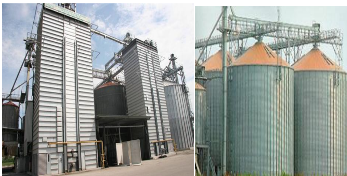
Рисунок 3.5 – Зовнішній вигляд Комплексу для очистки, калібрування, сушки і зберігання кукурудзи TECNOIMPIANTI
