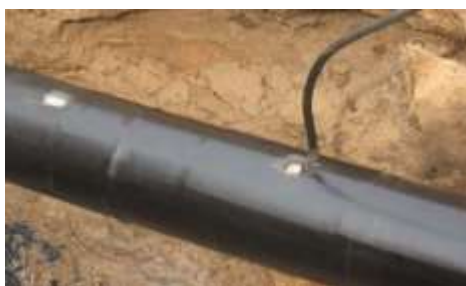
Рис.1.13. Спосіб під'єднання протектора до трубопроводу зварюванням
