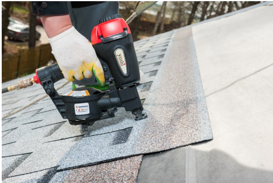
Рисунок 3.11. Встановлення гнучкої покрівлі
