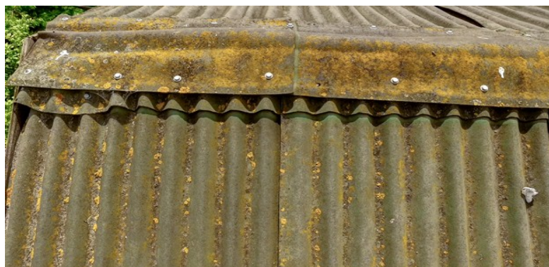
Рисунок 3.10. Приклад азбестової покрівлі
