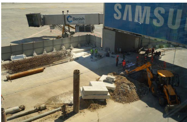
Рисунок 2.9 – Проведення будівельних робіт по розширенню трансферної зони терміналу D [85]
