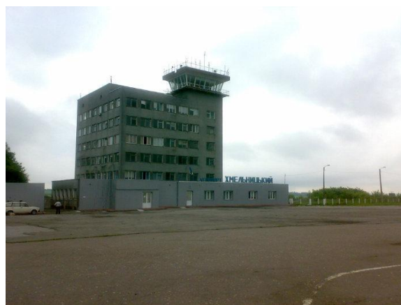
Рис. 2. Здание КДП в аэропорту «Хмельницкий» 2
