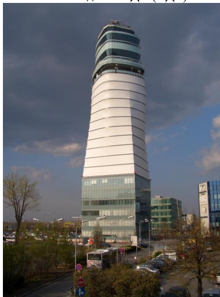
Рис. 5. Здание КДП, Vienna International Airport. Введено в эксплуатацию в 2004-2005 гг. 4
