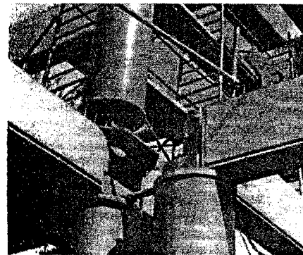
Рисунок 1.6 -Сталобетонний каркас багатоповерхової виробничої будівлі фірми Зіменс у Берліні
