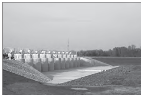
Фото 6.7. Водозабірна споруда найбільшого протипаводкового акумулюючого польдера в середній Європі, Угорщина, 2014 рік
