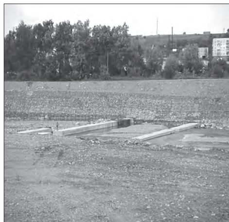
Фото 6.3. Донні пороги, побудовано на р. Дністер у м. Старий Самбір Львівської області (за рекомендаціями кафедри ГТБГ)
