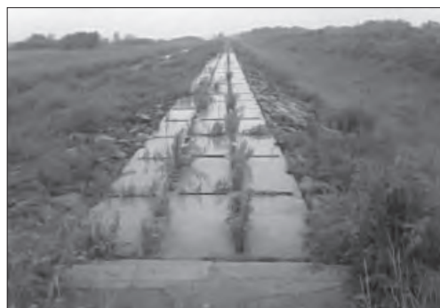
Фото 6.9. Реальний боковий автоматичний водозабір протипаводкової акумулюючої ємкості «Чайковичі» на р. Дністер у Львівській області
