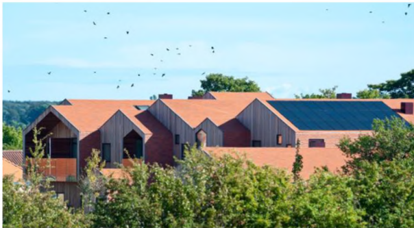
Рис.1.48 Засторування відновлювальних джерел енергії на даху будинку
