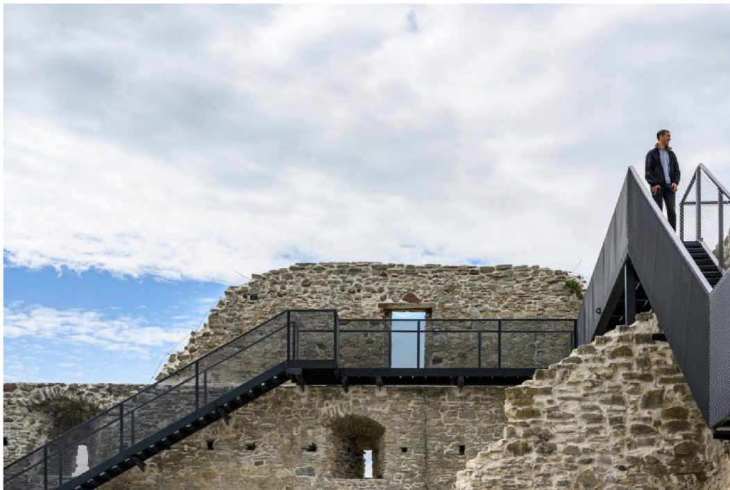
Рис.1.3.8. Сходи закріплені в стіну для додаткового маршруту по замку для кращого ознайомлення.
