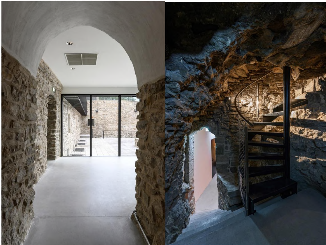
Рис.1.3.11. Оздоблення внутрішніх приміщень замку
