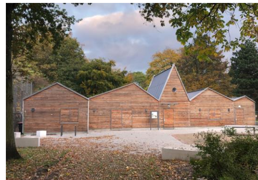
Рис. 1.55 Загальний вигляд будинку
