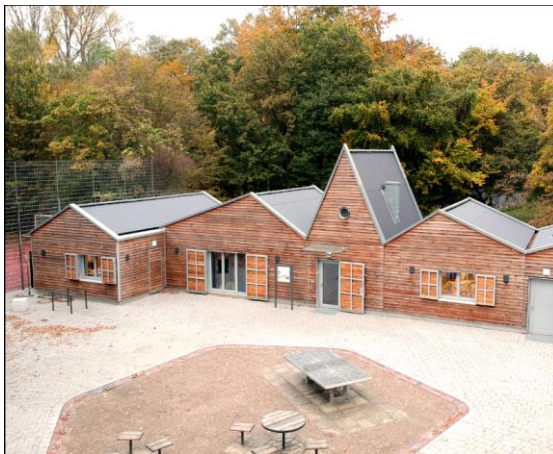
Рис.1.50 Загальний вигляд будинку
