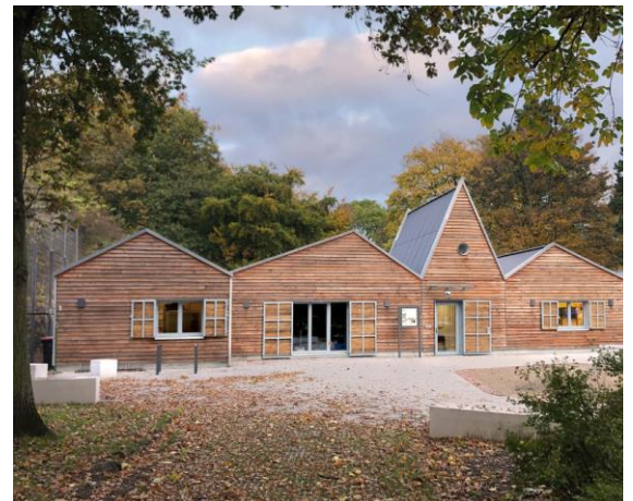
Рис.1.51 Загальний вигляд будинку
