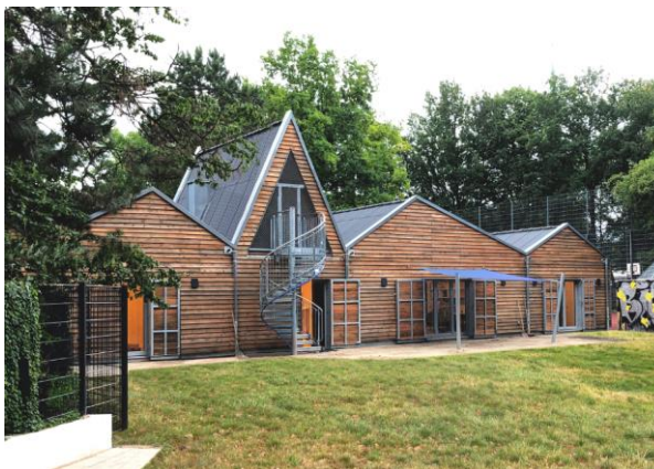
Рис. 1.54 Загальний вигляд будинку
