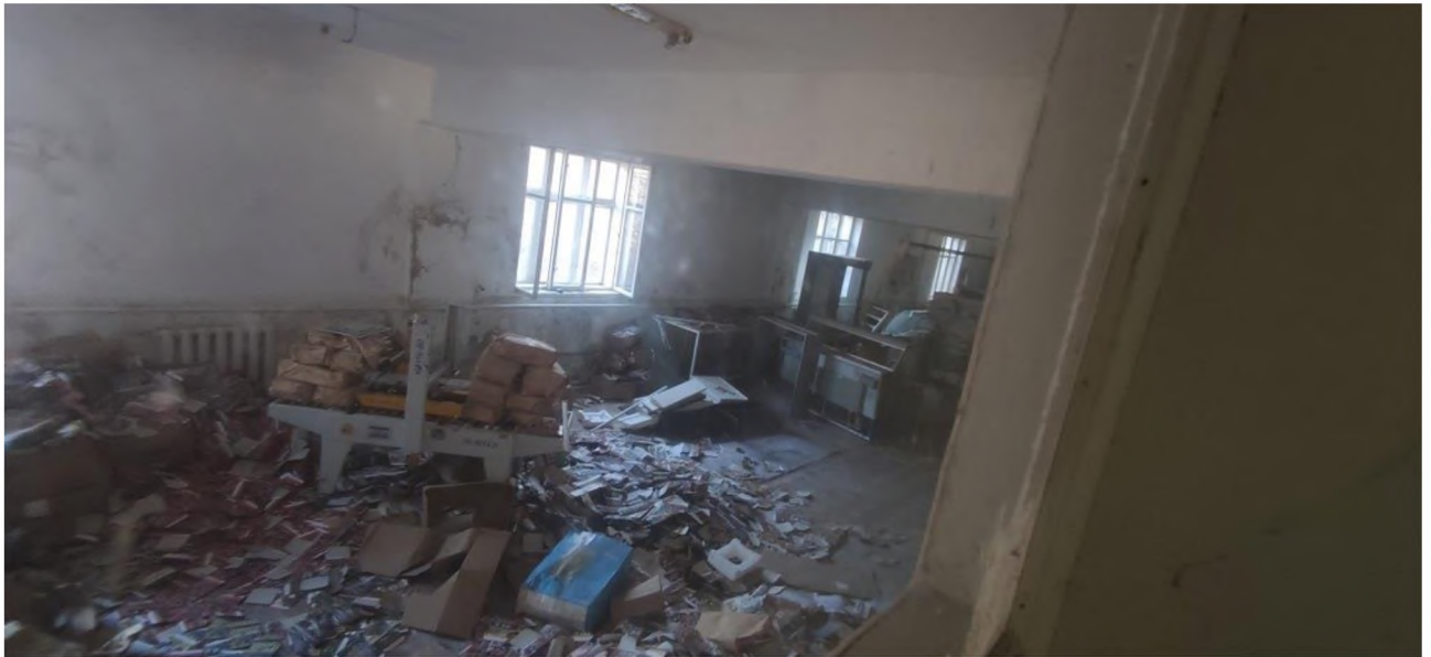
Рис. 3.13. Проведення робіт з відновлення занедбаних приміщень
