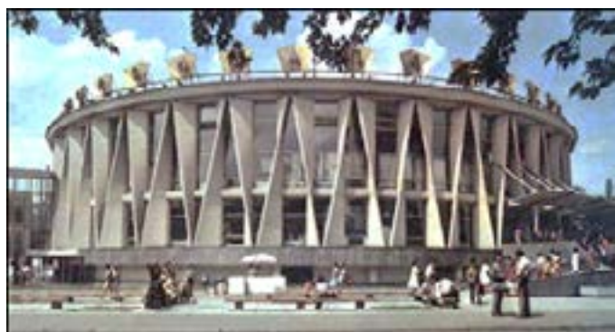
Рис. 1. Будівля Печерського ринку, загальний вигляд, 1990-і роки [3, с. 6]
