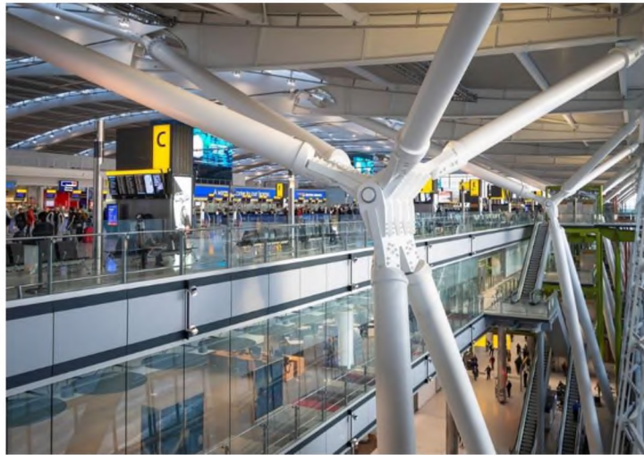
Рис. 1.4. Використання металевих конструкцій в інтер'єрі аеровокзалу Хітроу
