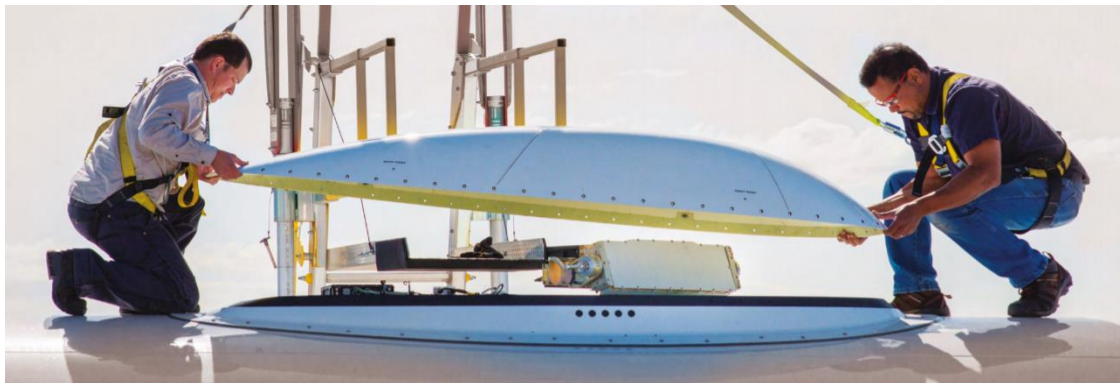
Рис. 2.16. Монтаж фюзеляжної антени та обтічника
