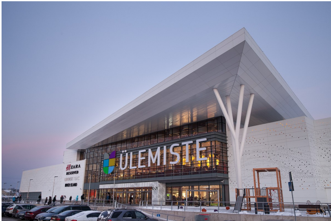
Рис. 2.4. Торговельно-розважальний центр «Ulemiste», м.Таллінн, Естонія
