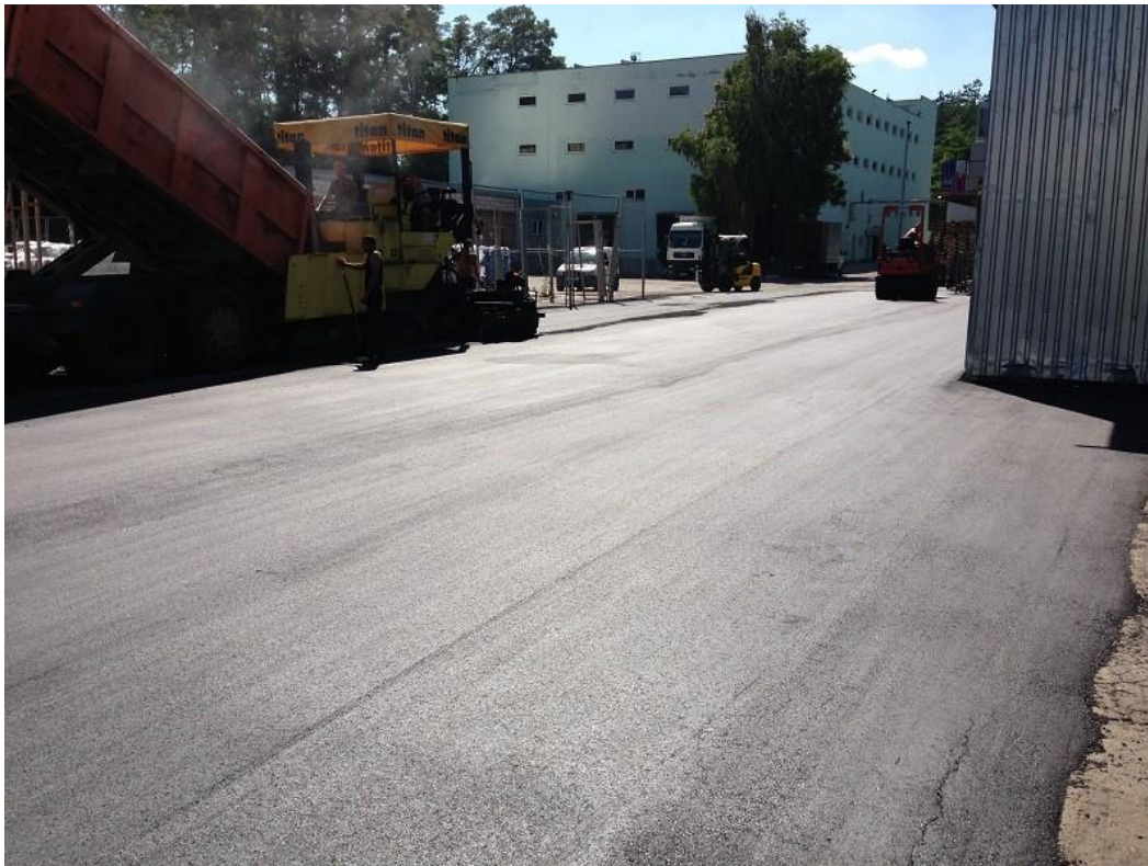
Рис. 4.1 - Укладання асфальтного покриття
