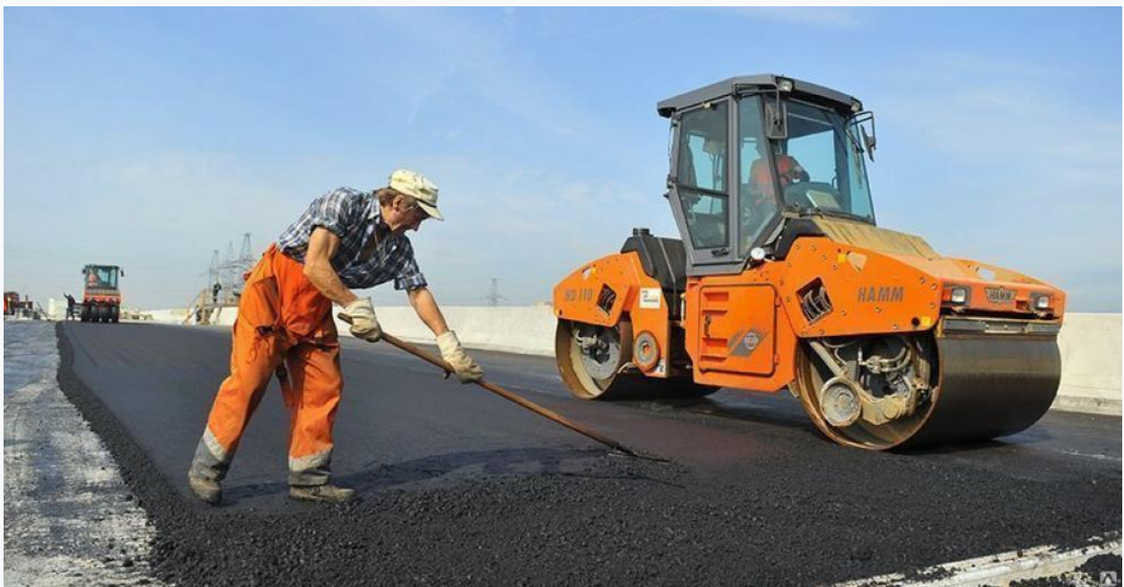
Рис.2.5 Укладання асфальтобетонного покриття
