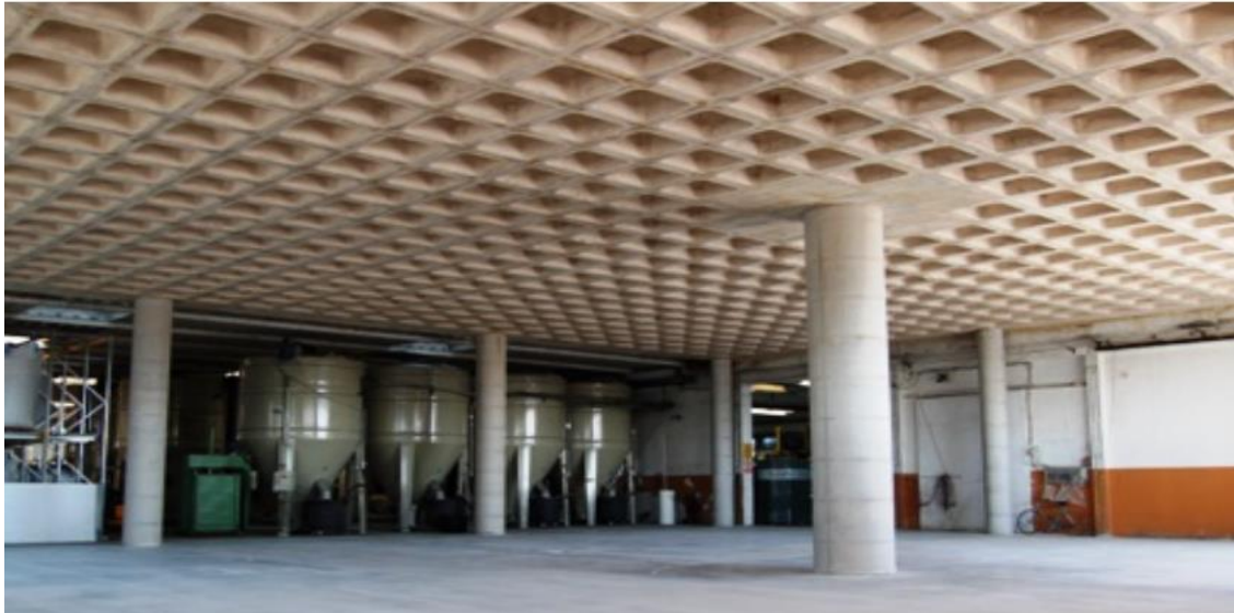
Рис. 10.14 Фрагмент монолітного часторебристого (кесонного) перекриття
