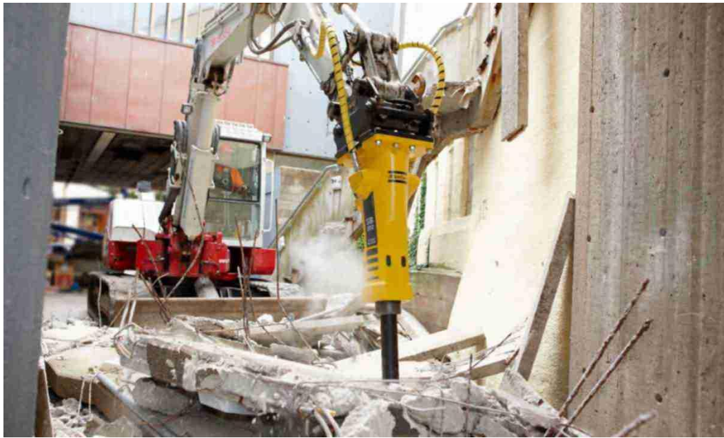
Рис. 3. Демонтаж залізобетонної конструкції
