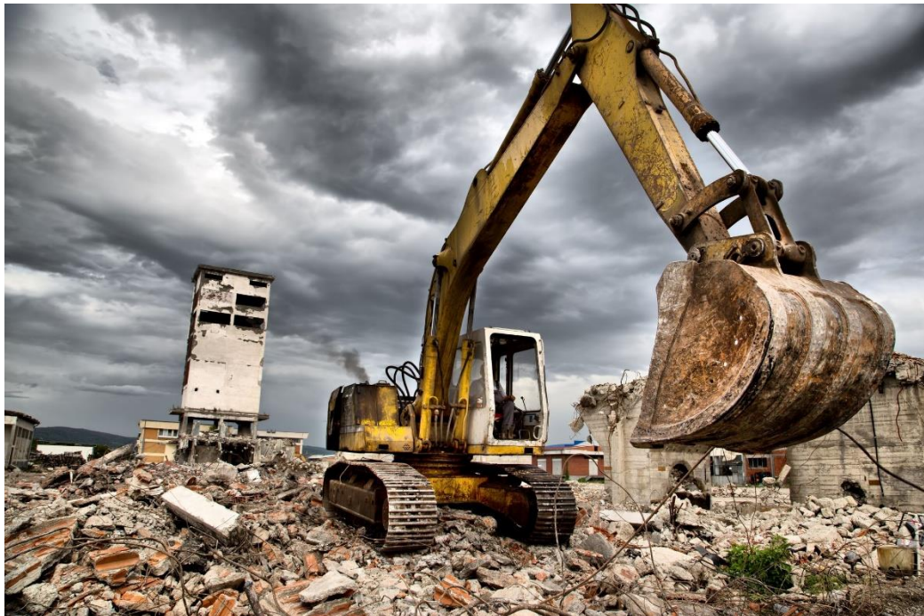
Рис. 2. Демонтаж аварійної будівлі
