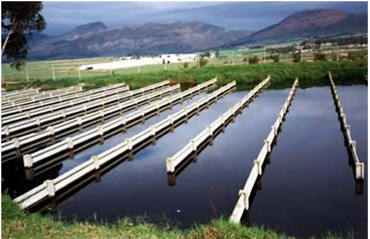
Рис. 2.4. Біологічні ставки для очистки стічних вод
