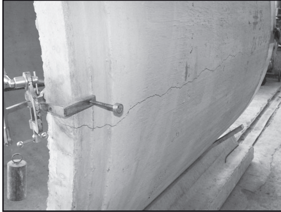
Рисунок 12. Тріщини на бічній поверхні труби (азимут 90°)
