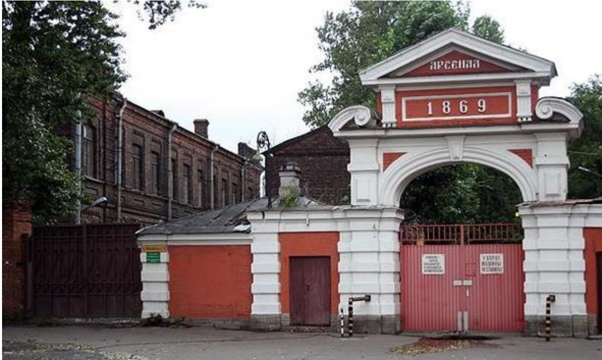
Рис.4.1.2. Нові корпуси на вул.. Московській.
