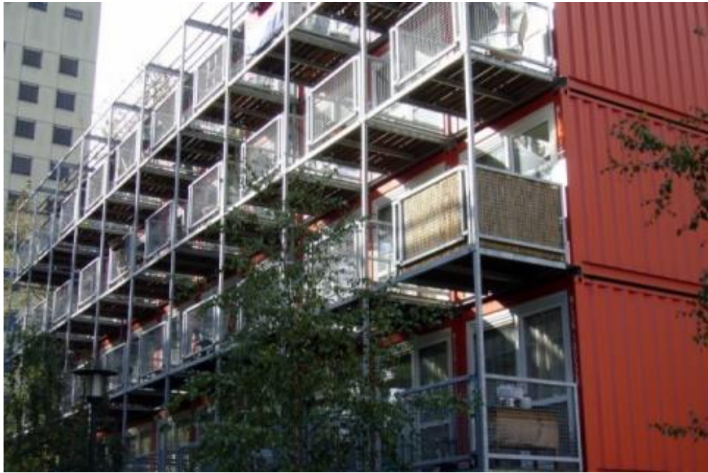
Рис. 3.4.5.а. Будівництво із морських контейнерів
