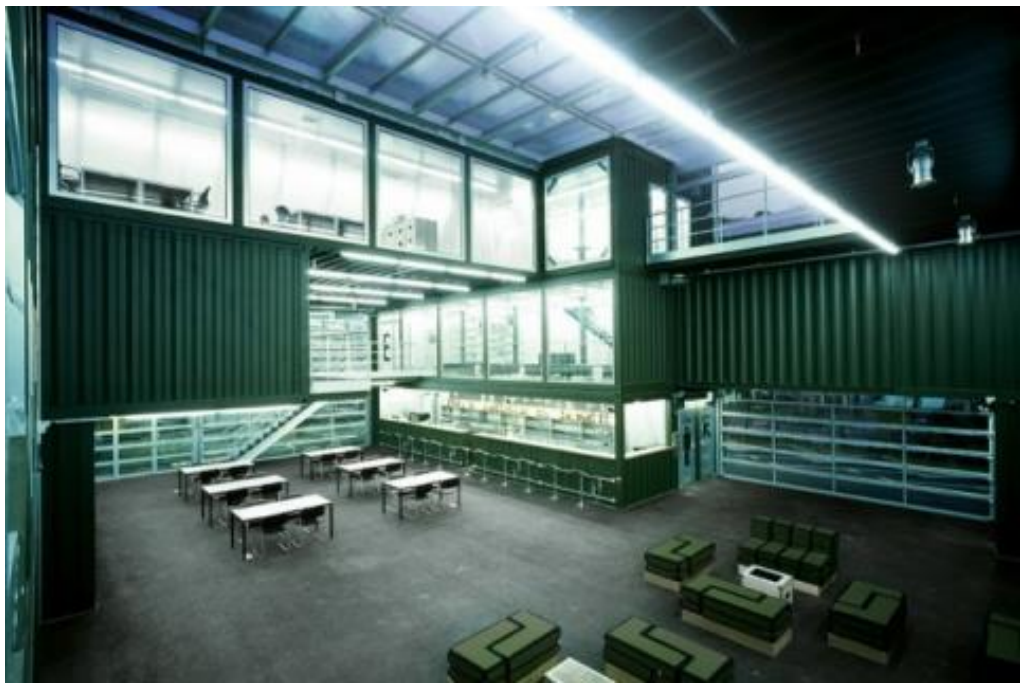
Рис. 3.4.5.б. Будівництво з морських контейнерів
