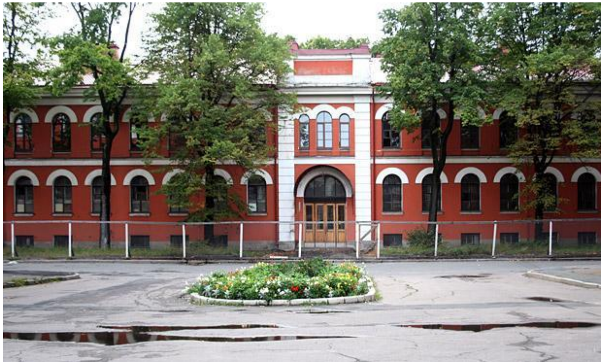
Рис.4.1.1.Нові корпуси на вул. Московській.
