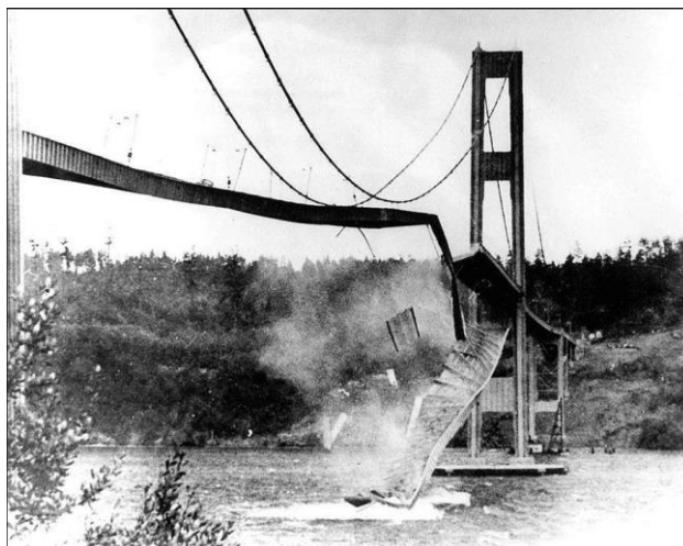
Рис. 1.1. Зруйнований міст Такома
