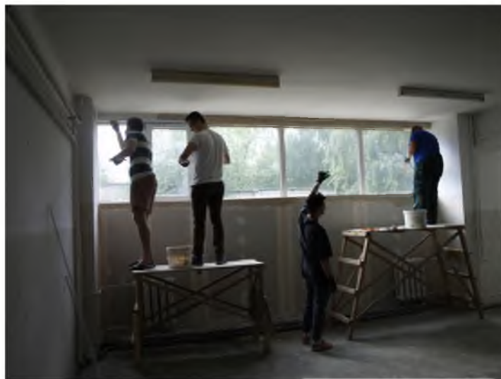
Рис. 11. Навчальний корпус №18, виконання ремонтних робіт студентами НАУ, 2019 рік. Фото Г. Агєєвої
