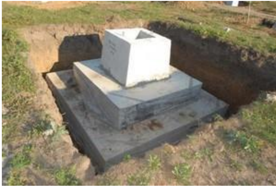
Рис. 2.1 Фундамент стаканного типу
