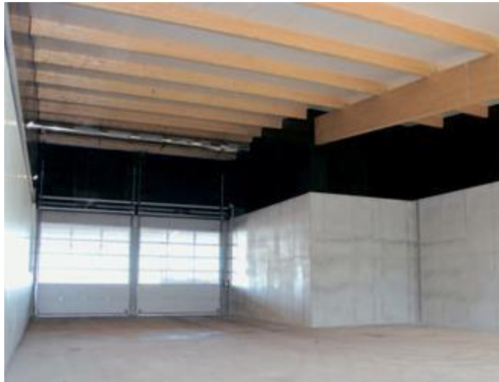
Рис. 2.21. Біогазовий реактор використовує "сухий" метод ферментації (вид зсередини)
