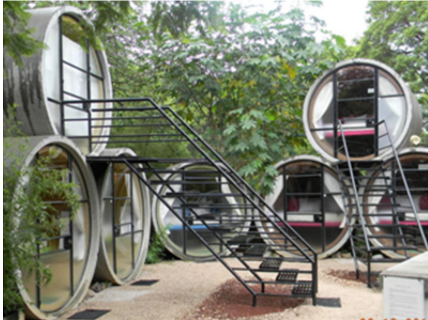
Рис. 1.9. Tubohotel. Загальний вигляд.
