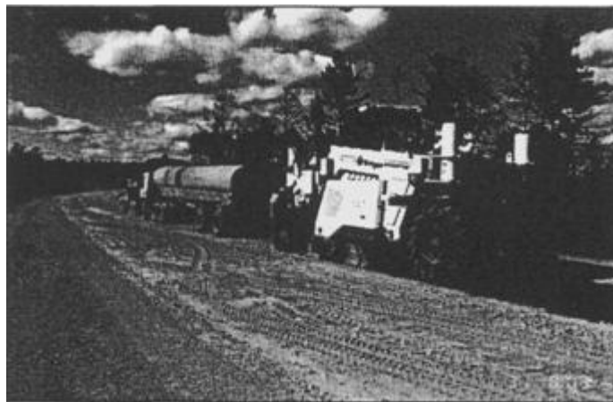
Рис. 6.3 Автопотяг, що складається з ресайклера, бітумовоза і поливомийної машини
