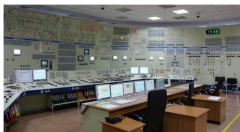
Рис. 1.9. Тренажер блочного щита управління реактору ВВЕР-440, на якому відтворюють послідовність дій персоналу під час розслідувань інцидентів [58]
