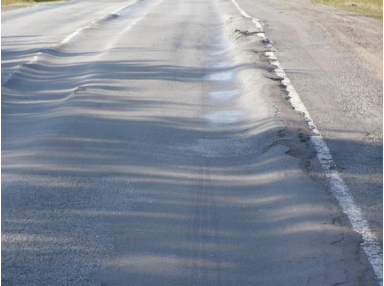
Рис3.1. Колії на автомобільних дорогах
