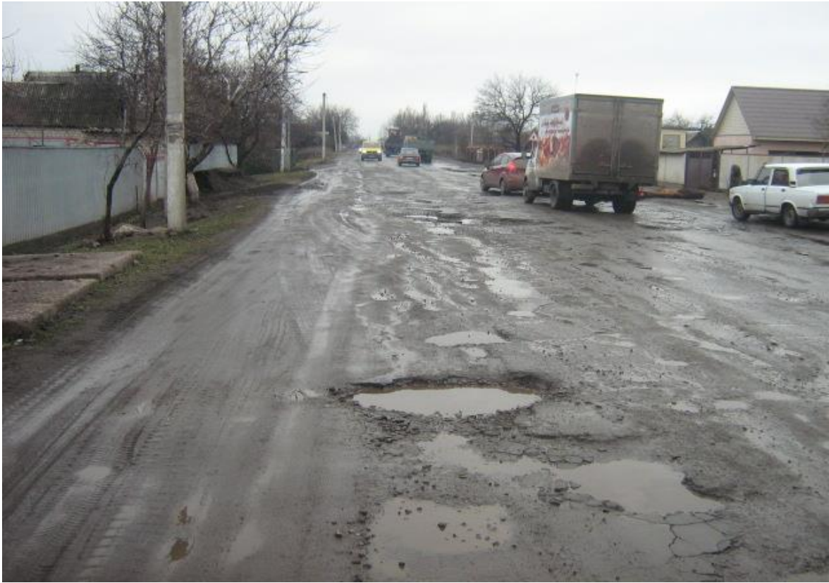
Рис3.2. Вибоїни на штучному покритті
