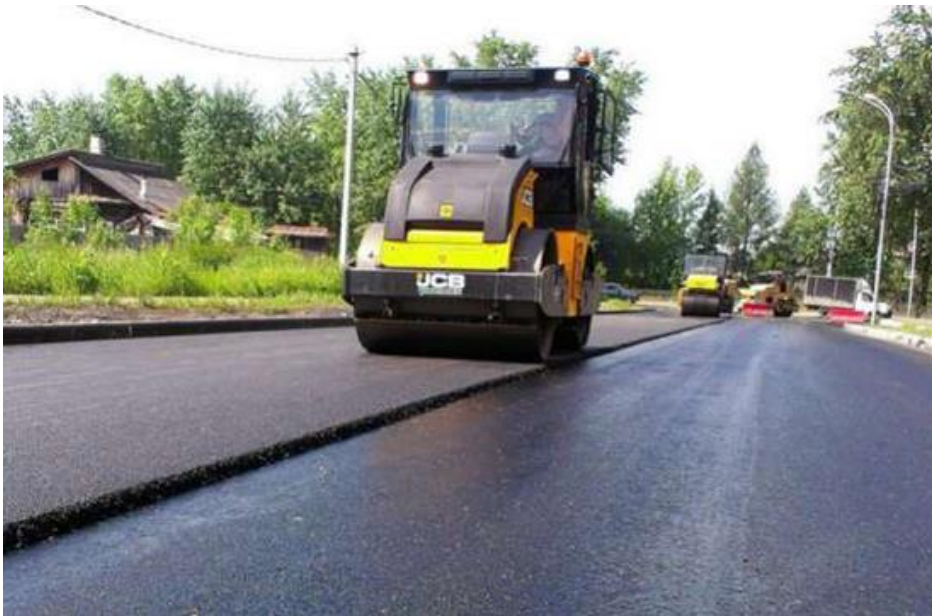
Рис.4.3.1.Будівництво «гумових екологічних доріг»
