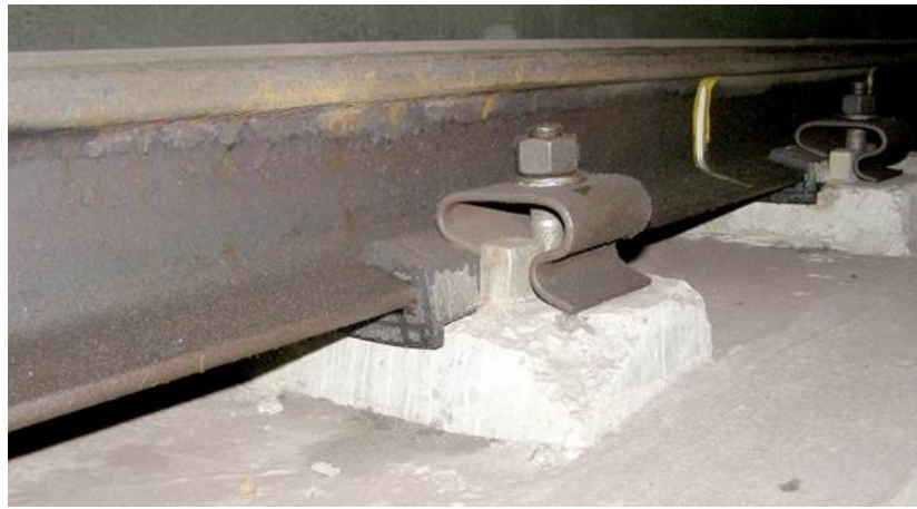
Рис. 4.5. Місце встановлення датчиків під рейкою у тунелі метрополітену
