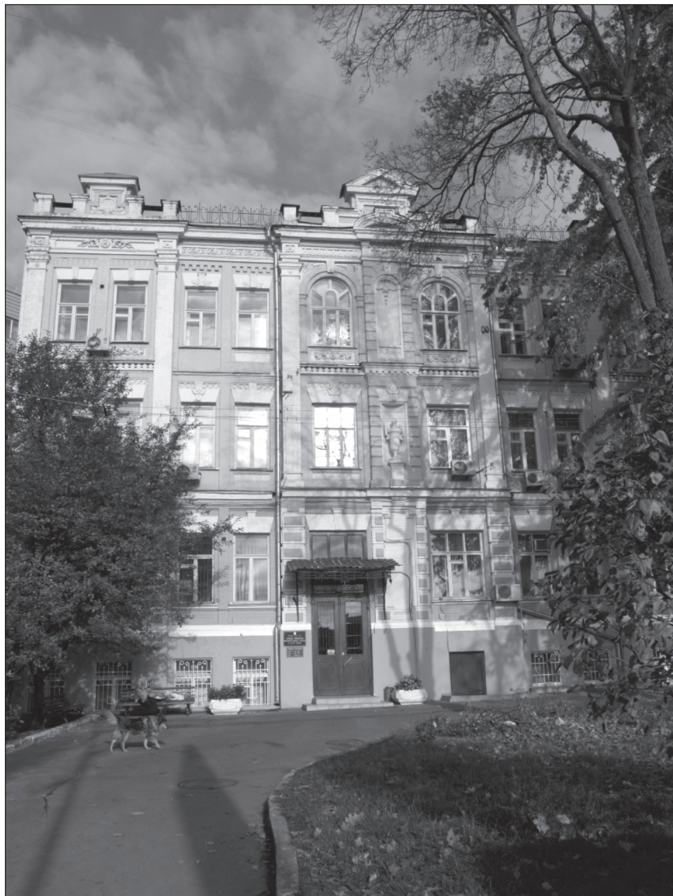
Рисунок 4. Фасад здания, ул.Бульварно-Кудрявская,16. 2011 г.
