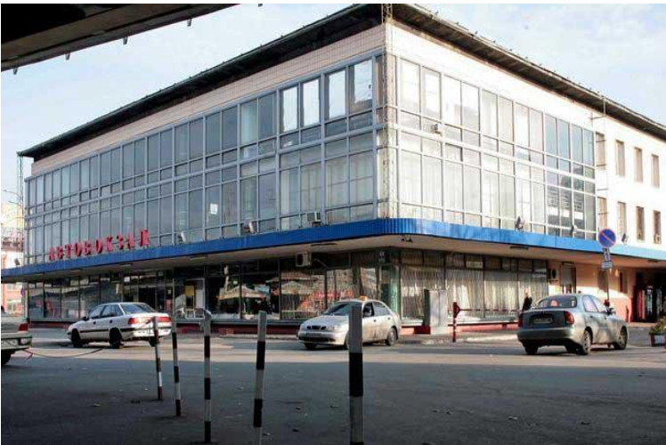
Рисунок 6.23 – Центральный автовокзал «Київ-1». Зовнішній вигляд
