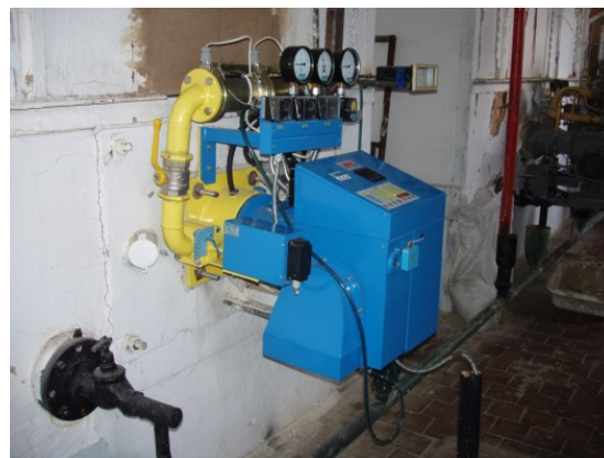
Рис. 10. Котлоагрегат НИИСТУ-5 после модернизации горелкой ГБГМ-0,85 НД с инсталлированной системой
