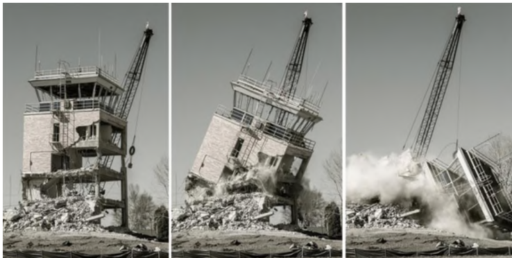
Рис.2. Демонтаж будівлі КДП, Hartsfield-Jackson Atlanta International Airport, США [9, с.3]
